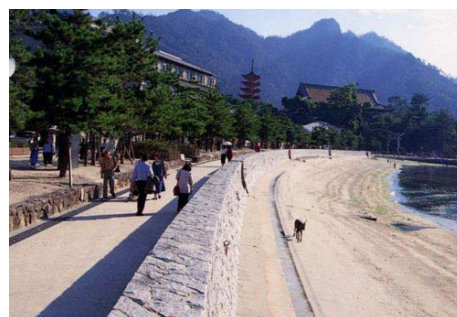
廿日市市宮島町 厳島港海岸 (県HPより)
