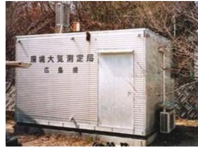
常時監視測定局舎（大崎中野小学校測定局舎）
