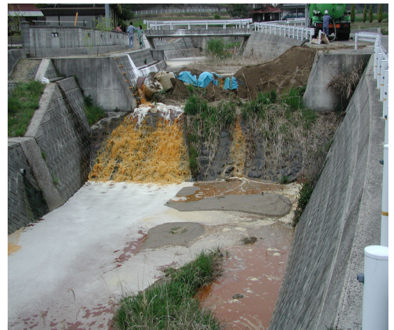
水質事故の状況
