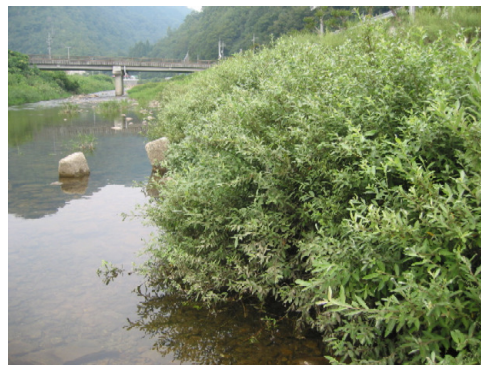
多自然型工法による河川整備（長瀬川）
