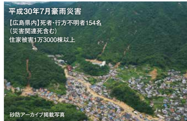
平成30年7月豪雨災害 【広島県内】死者・行方不明者154名 (災害関連死含む) 住家被害1万3000棟以上 砂防アーカイブ掲載写真
