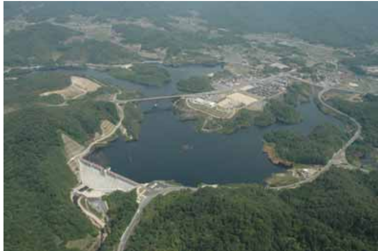
図 4.7.3 沼田川水系・福富ダムの状況
