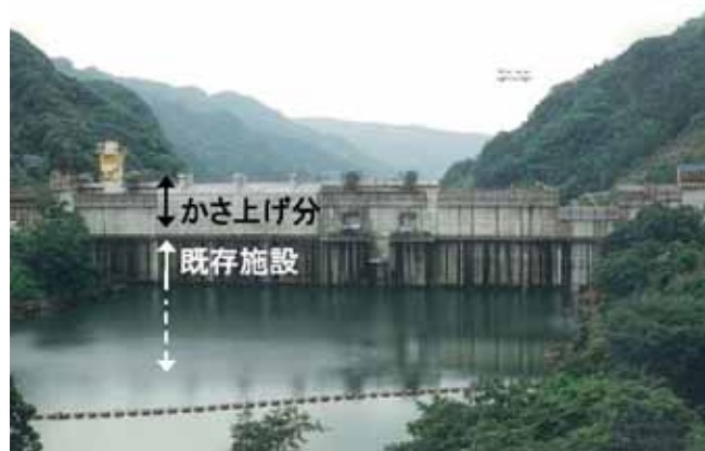
図 4.7.8 ダム再開発(かさ上げ・掘削)のイメージ
