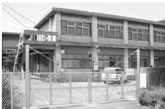
観音新町の新中間書庫と新設の門扉 正面建物の後に残り2棟がある
