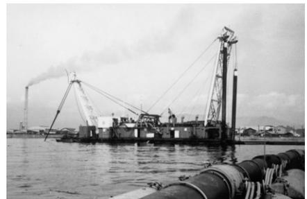
浚渫土による埋立て 浚渫船（右） 浚渫土の埋立地内への放出（中） 放出後、ブルドーザーにて押し、整地（左）
