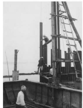
矢板護岸 鋼板を立込み（右）、打ち込んで護岸とする。奥の方は打込完了、手前の高い方は立込のまま（左）。
