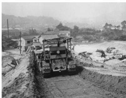
臨港道路 山土の搬入（中）ブルドーザーによる均し（左）
