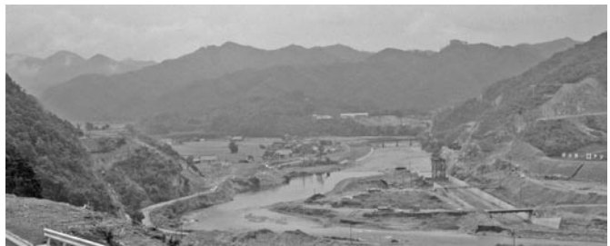
建設中の土師ダム
