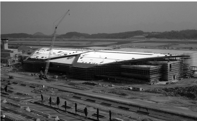
建設中の新広島空港ターミナルビル (平成5年2月28日)
