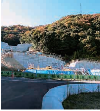
砂防堰堤工事が進む八木地区
