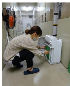
写真 11 空気清浄機のフィルター点検
