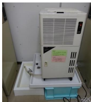
写真6 大型除湿機と排水パン
