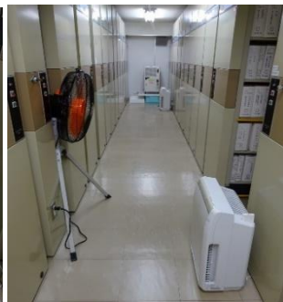
写真7 サーキュレーターと空気清浄機
