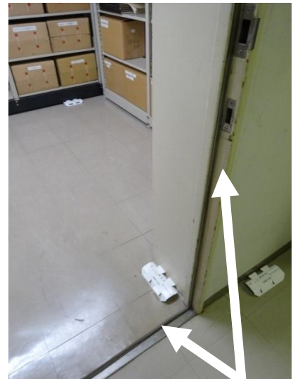
写真4 ドアの隙間をふさぐスポンジの目張り
