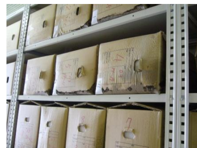
雨漏りで濡れたダンボール箱
