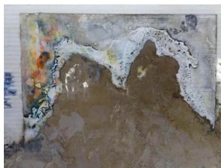
写真9 写真の画像に泥が付着している
