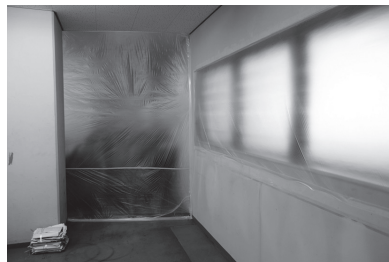
写真17 荷解整理室の窓側
