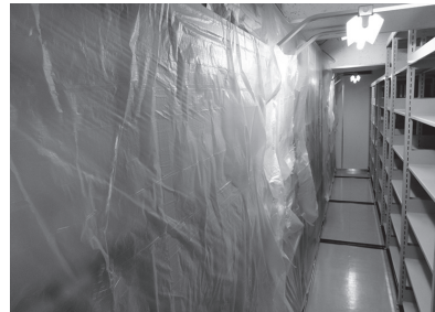
写真10 レーンの内部の隔離
