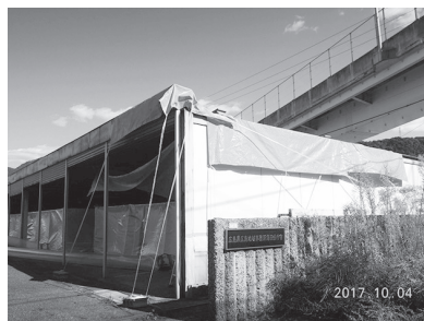
写真23 屋根の雨漏り対策
