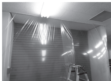
写真46 荷解室シャッター入口
