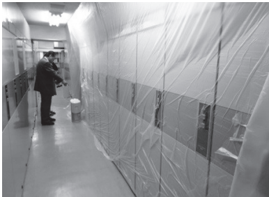
写真9 レーンの通路側の隔離
