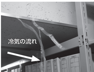
写真39 冷気の流れを確認する紐
