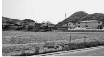
安浦町の中畑川破堤箇所付近 (平成31年4月)
