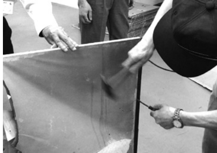
写真42 襖の縁を取り外す。
