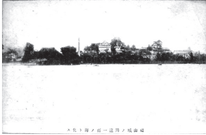
写真11 福山城周辺の水害被災状況
