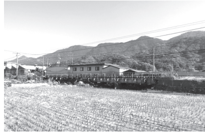
写真16 安芸中野駅付近の避溢橋
