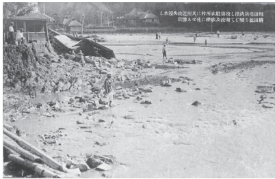
写真18 水害による安村役場・駐在所付近流失の状況
