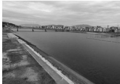
写真22 太田川放水路
