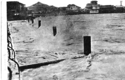
写真9 濁流に襲われる相生橋
