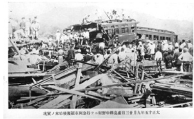
写真15 安芸中野付近特急列車脱線転覆事故の現場状況
