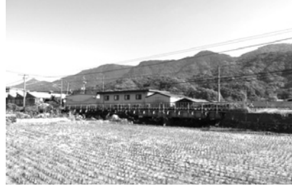
写真16 安芸中野駅付近の避溢橋
