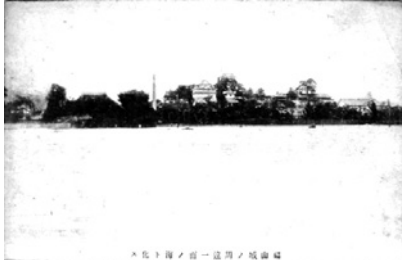
写真11 福山城周辺の水害被災状況
