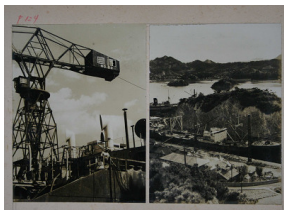
124頁 因島には近代的な設備を持った造船所がある。今ここでは捕鯨 (船脱カ) が建造されている。左図はハシダチ丸(12,000トン) 右図はタドツ丸(9,000トン)
