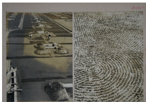
125頁 瀬戸内海沿岸には至るところに塩田がある。気候がよいので太陽熱と海水とを利用して塩を作ることができる。右は塩水と砂との田を特殊の器具でかきまぜたあとの美しい模様。
