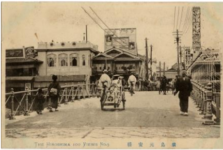
元安橋（東から）
