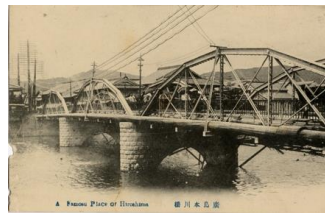
本川橋（南東から）
