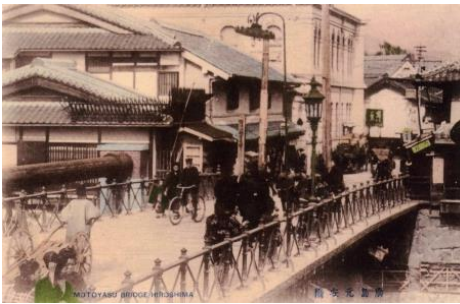
元安橋（南西から）
