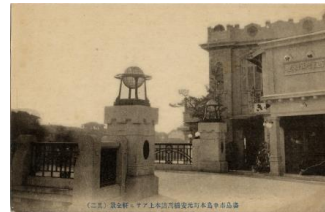
元安橋西詰（アサヒ軒前）
