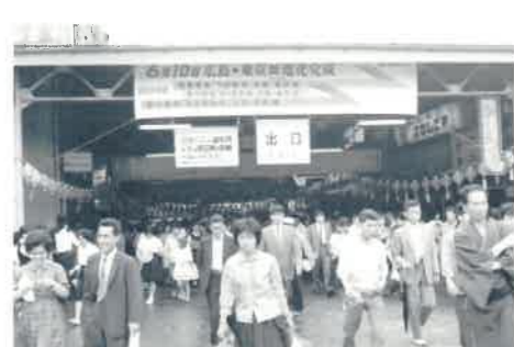
電化初日の広島駅正面集札口(昭和37年6月10日) 200407-5551
