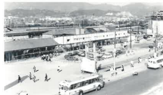
工事中の広島駅東側(昭和39年5月9日) 200407-5551
