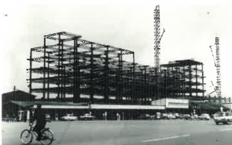
建設工事中の広島民衆駅(昭和40年) 200407-3014
