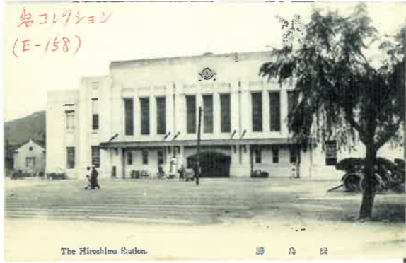
鉄筋コンクリートで新築開業した広島駅（大正10年代） 200407-3114
