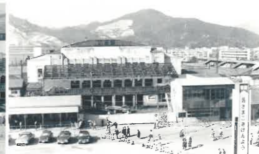
解体工事中の広島駅(昭和39年5月9日) 200407-5551
