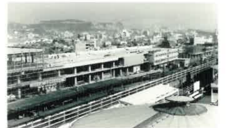
工事中の山陽新幹線広島駅(昭和49年2月16日) 200407-3575
