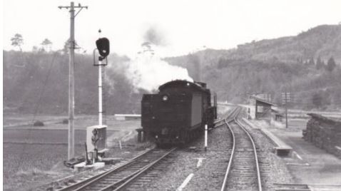
小奴可駅から内名方面へ向けて発車した蒸気機関車 昭和 43.12.28 (200407-5550) 機関車が走っている線路は、現在廃止されている。
