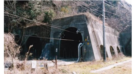
小屋トンネル西口 左側（山側）は旧小屋トンネル 平成13年2月20日（200407-5560） 電化工事の際、右側（海側）の新トンネルに落石覆いが増設された。
