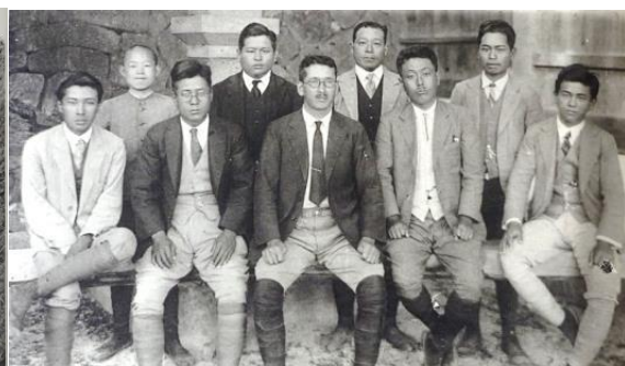
三呉線の第三工区（安芸幸崎～忠海方面）の敷設工事を担当した松浦組社員（同左）
