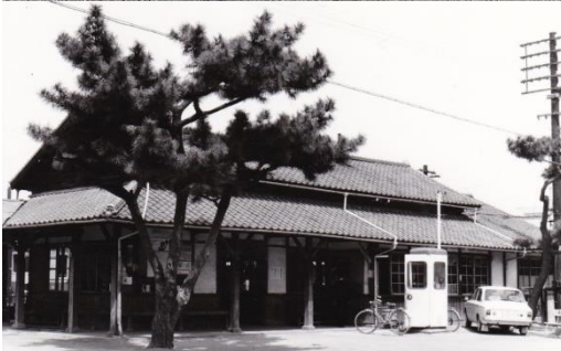
坂駅 昭和43年4月7日（200407-5560） 明治36年（1903）12月27日の官設線海田市～呉間開業時に設置された駅舎。昭和54年（1979）1月に鉄筋コンクリートの2代目駅舎に建て替えられ、現在は平成12年（2000）7月に橋上駅舎として改築された3代目駅舎となっている。
