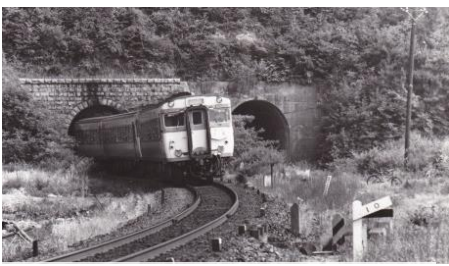
小屋浦〜水尻間 電化前の亀石トンネル西口を出る急行「吉備」 昭和43年6月2日（200407-5560） 右側が複線化用に掘られた新トンネル。
