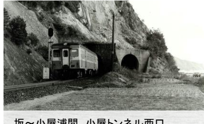
坂〜小屋浦間 小屋トンネル西口 昭和41年2月5日（200407-2975） 右側（海側）が複線化のため戦時中に掘られた新トンネル。昭和43年（1968）4月から着手された呉線電化工事では、規格の大きい新トンネルが使われ、左側の旧トンネルは廃止された。
