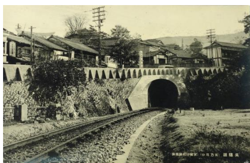
呉トンネル（呉～安芸阿賀間）の呉側入口（同右） 休山の下を通る呉トンネルは全長2,582mで呉線最長のトンネル。掘削工事は昭和2年（1927）11月から始まったが、周辺地域で断水が発生するなど、大変な難工事であった。
