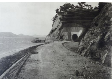
安芸幸崎～忠海間（岡山跨線橋） 『三呉線三原口第三工区土木其他工事記念写真帖』
