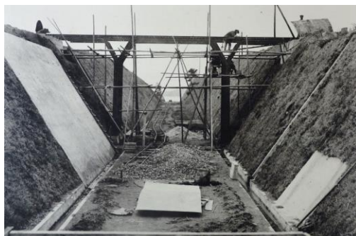
安芸幸崎～忠海間（鴨ノ首隧道） 昭和7年1月（200407-2434）
