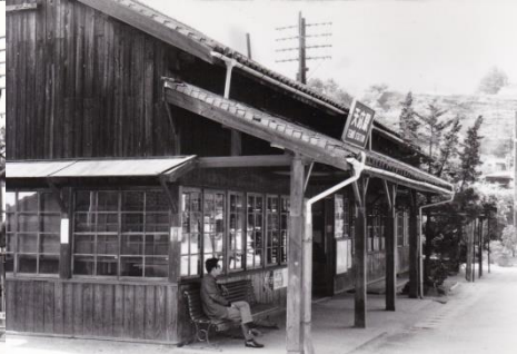
天応駅 昭和43年4月21日（200407-5560） 坂駅と同じく明治36年（1903）の官設線開業時に設置された駅舎。外観は変わっているが、木造駅舎は今も健在。
