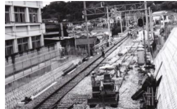
工事中の新・川原石駅 平成10年9月30日 （200407-5560）
