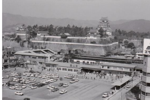
新幹線工事で仮営業中の福山駅
