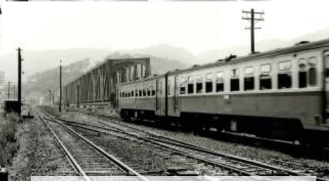
横川駅西方 旧線を行く列車と新鉄橋
