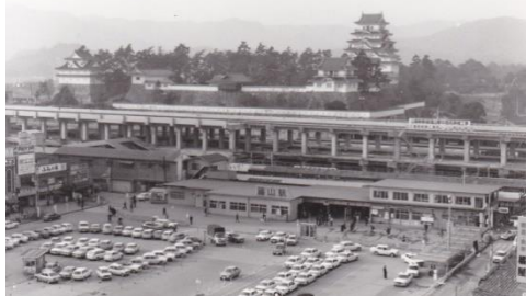
新幹線高架工事中の福山駅
