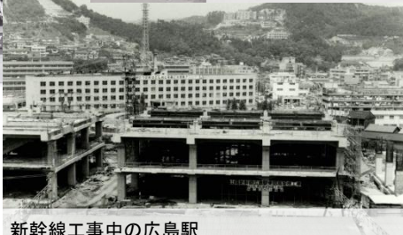
新幹線工事中の広島駅
