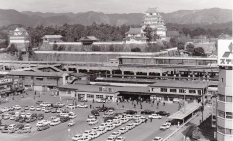
新幹線高架工事中の福山駅
