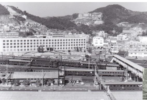
新幹線工事以前の広島駅
