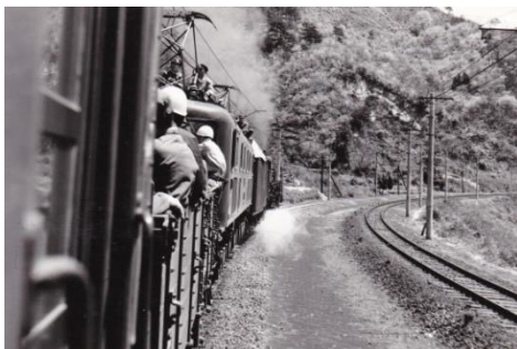
瀬野～八本松間にて 電化入線試験列車 昭和 37. 4. 28 200407-5549
