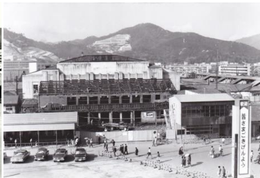
工事(解体)中の広島駅と仮駅 昭和 39. 5. 9 200407-5551
