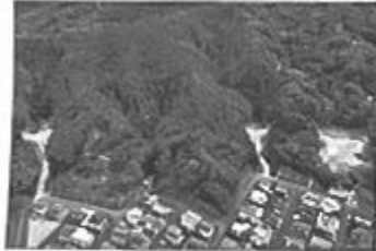
溪間工(広島市)
