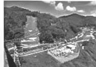
山腹工(東広島市)
