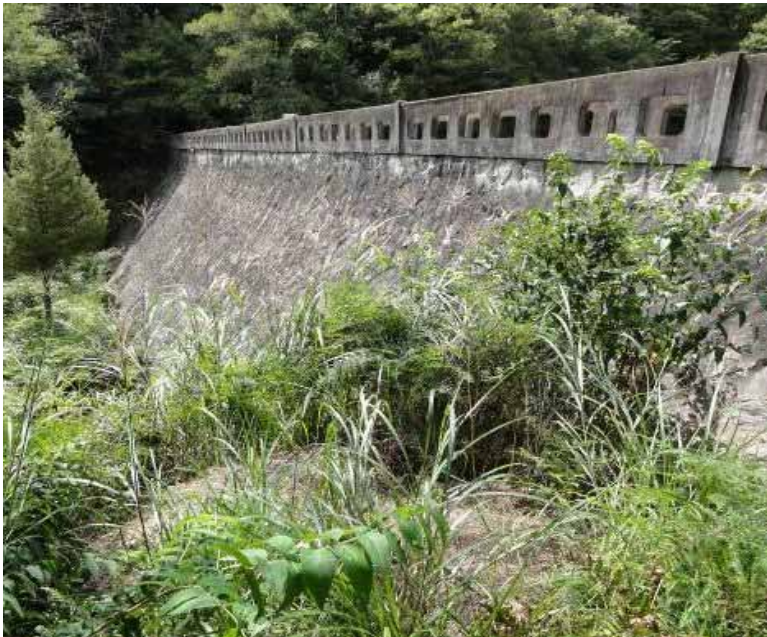
明賀池堤体の前面
