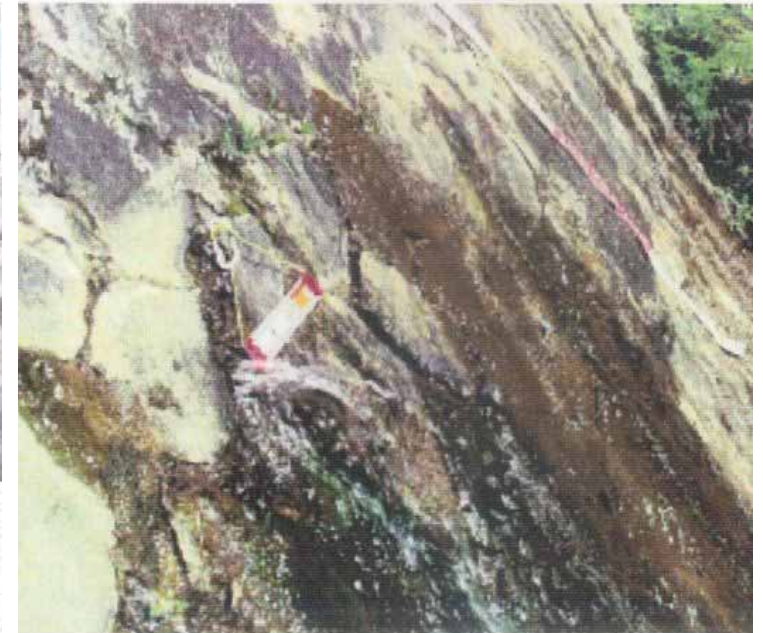
クラックと漏水の状況
