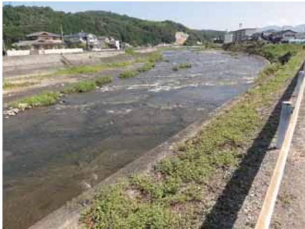
西城川・車橋付近の河道状況【河道内樹木が少ない】
