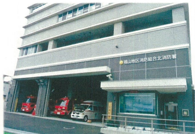
完成したばかりの消防署には最新設備と 早く出動するための工夫がいっぱい
