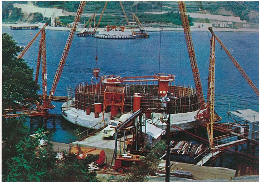
S 46・10 P 3 ケーソン工沈下中
