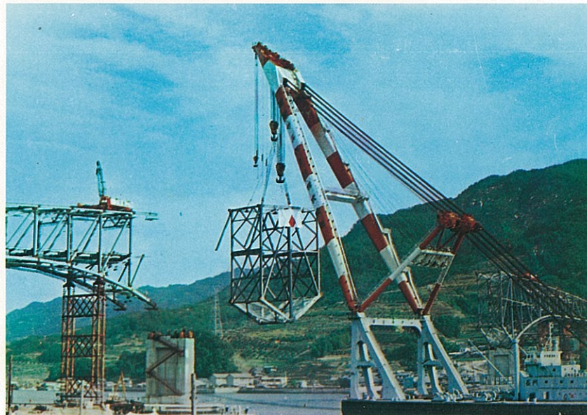
S 47・10 連続トラス・ブロック架設 (大柿町側)
