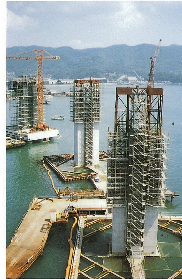
■下部工工事 P5, P6, P7 橋脚躯体施工中 (昭和60年8月)
