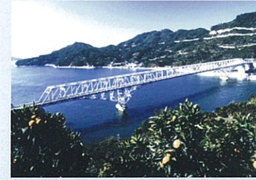
蒲刈大橋(2号橋)
