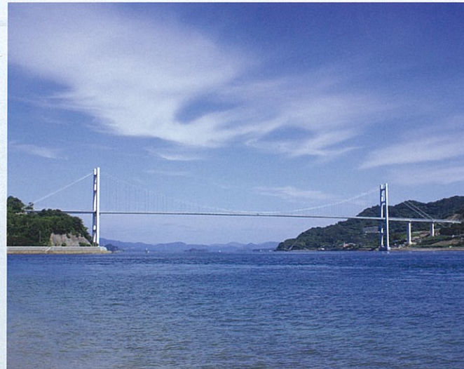
豊島大橋(3号橋)
