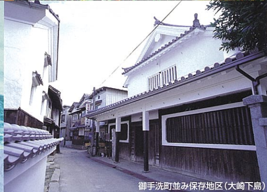
御手洗町並み保存地区 (大崎下島)
