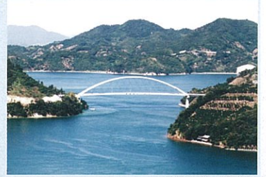
岡村大橋(7号橋)
