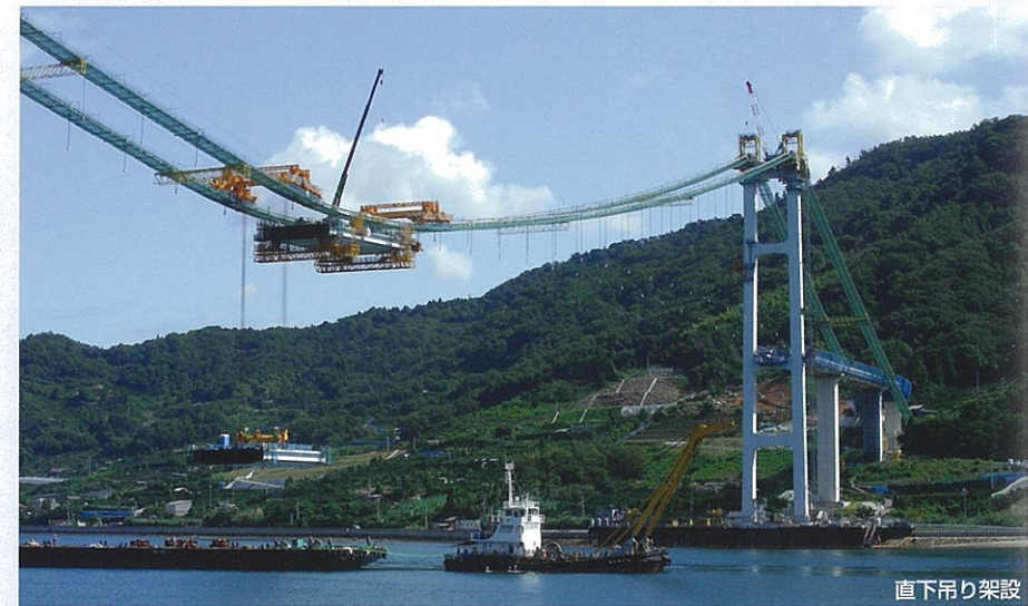
直下吊り架設
