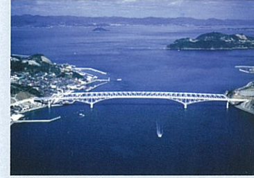
豊浜大橋(4号橋)
