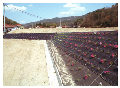
⑫定植直後の法面全景
