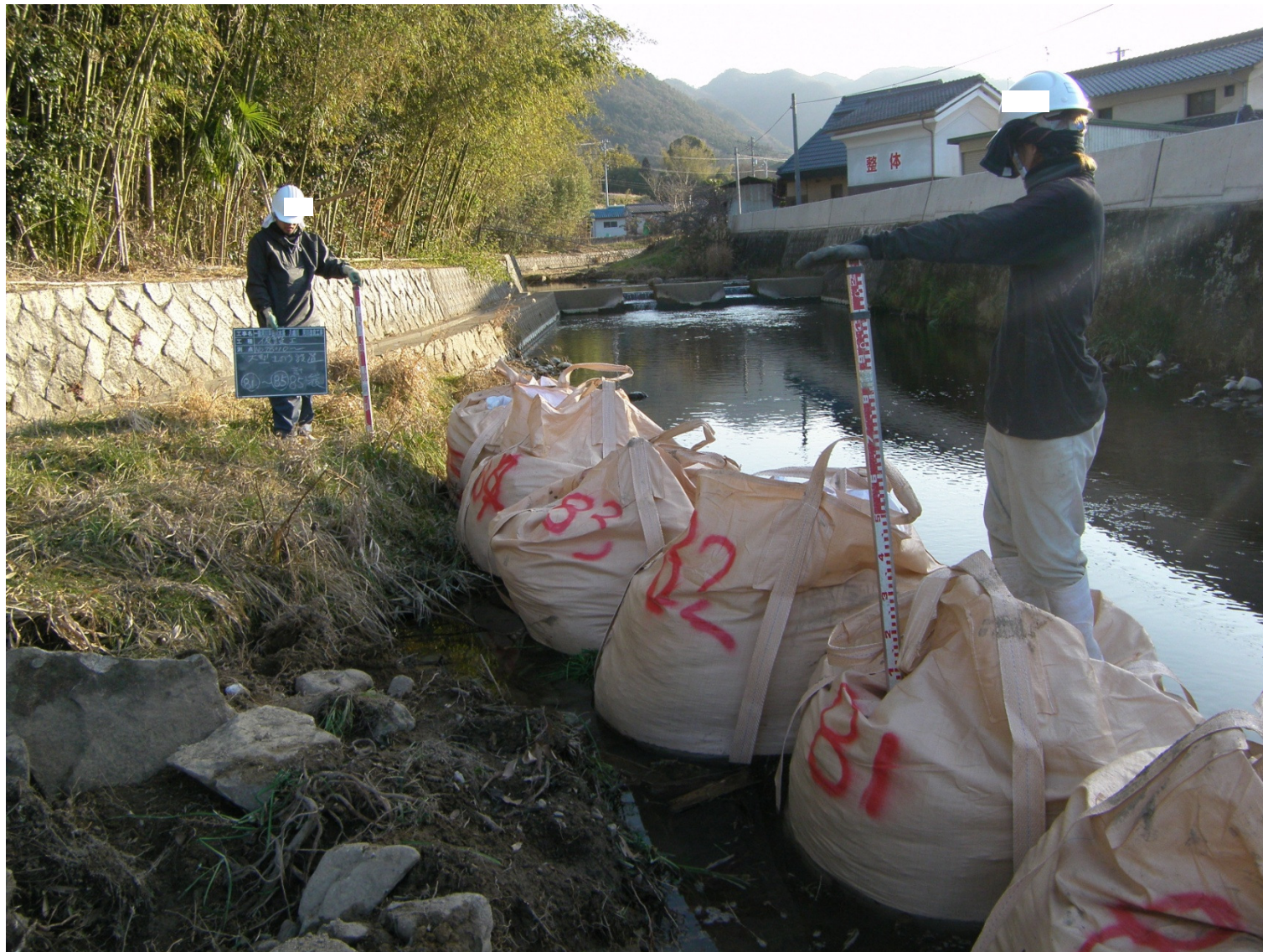
本件工事期間中（平成 22 年 1 月）に設置された大型土のう袋の設置状況（番号 81～85）（請負業者 A 社撮影）
