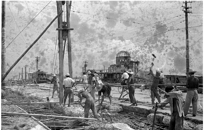
相生橋復旧作業 (広島平和記念資料館提供)
