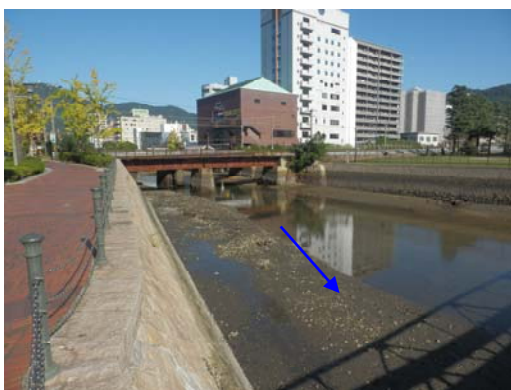
④堺川下流 (JR橋梁下流)
