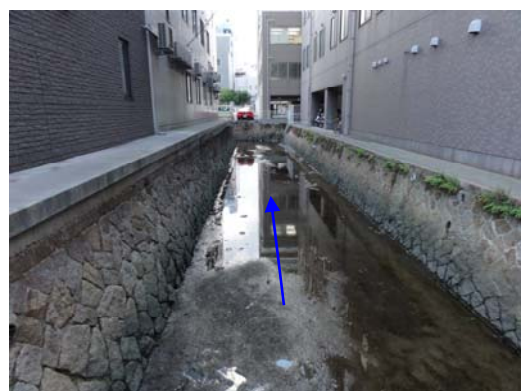
③内神川下流(開水路下流端)
