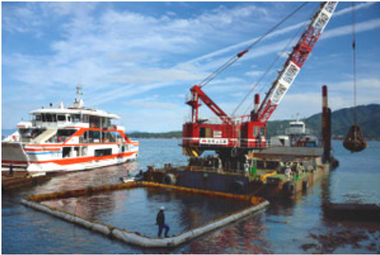
捨石投入状況
