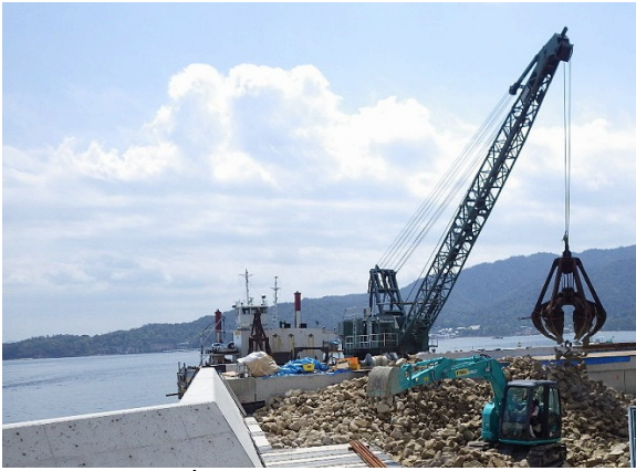
裏込石投入状況
