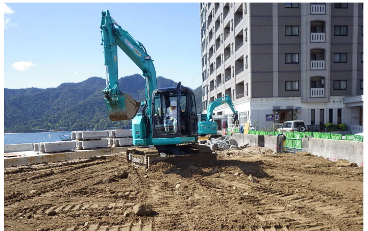
埋立土敷均状況
