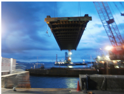
160t 吊起重機船による連絡橋撤去
