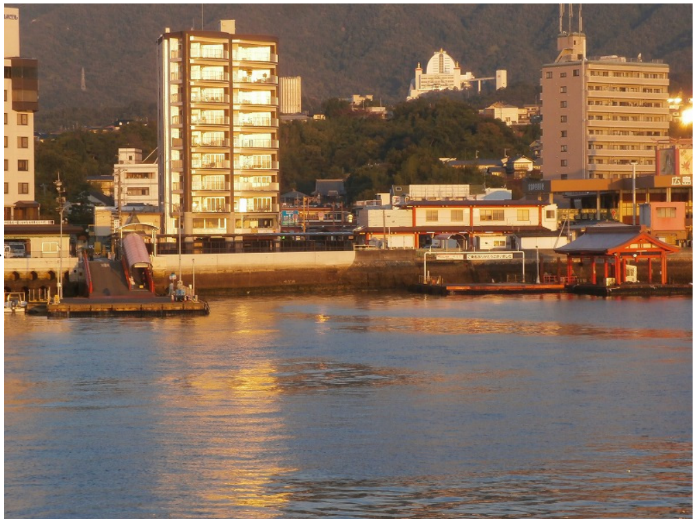
連絡橋移設後の浮棧橋（左）と、連絡橋が撤去された旧浮棧橋の浮函（右） 旧浮棧橋の浮函は近日中に撤去します。
