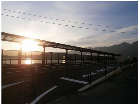
埋立1工区には、屋根設置、舗装等を行い、通路を整備しています
