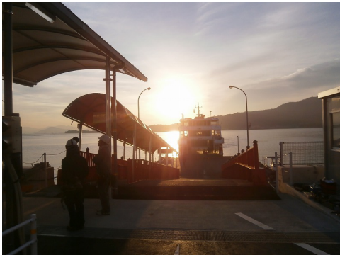
10月29日の始発便の到着前に、連絡橋の移設を完了
