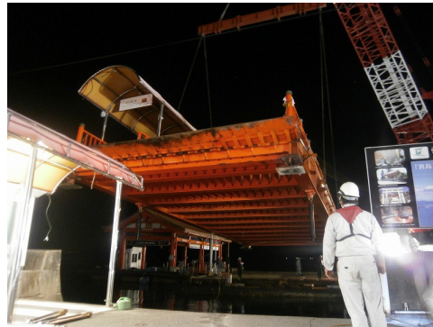
最終便の出港後に、連絡橋の撤去を開始
