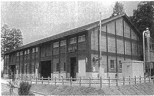
写真1 木材実験棟 (建築面積968㎡)
