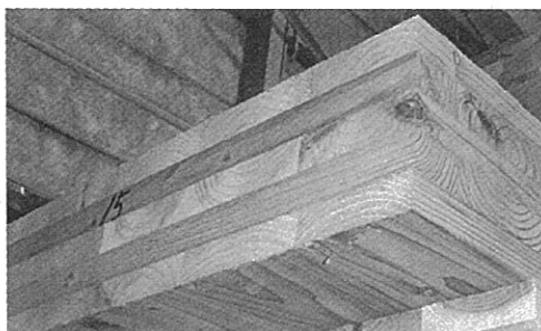
図2 スギCLT5層5プライ
