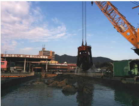
掘削した土を土運船に積み込みます。
