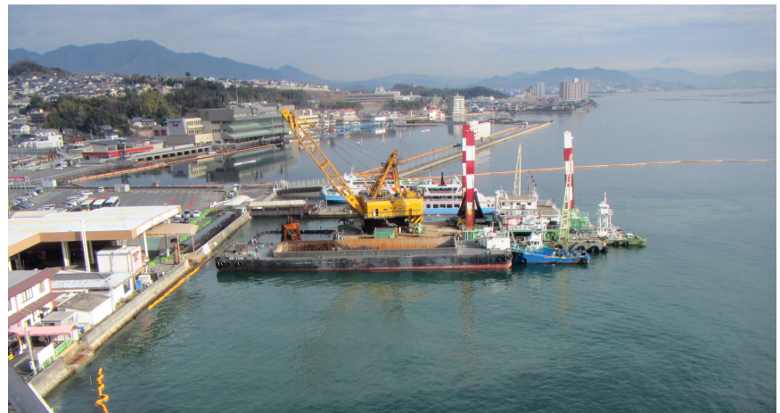
グラブ浚渫船(黄色いクレーン)と土運船(手前の黒い船)で施工します。
