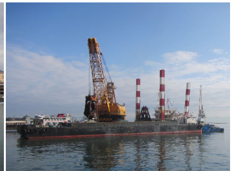
土運船は1,500m3の積載が可能です。
