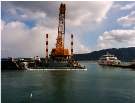
浚渫船により海底面の掘削(床掘)を行います。
