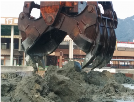
1回で約9m3の掘削ができます。
