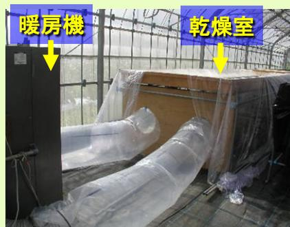
暖房機のダクトからパネルを垂直に立てた乾燥室へ送風して乾燥させます。
