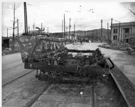
横川終点近くで被爆した 100 形（115 号）電車。大正元年開業当時の木造電車のため、台車のみ燃え残っている。（広島平和記念資料館提供（米軍撮影））
