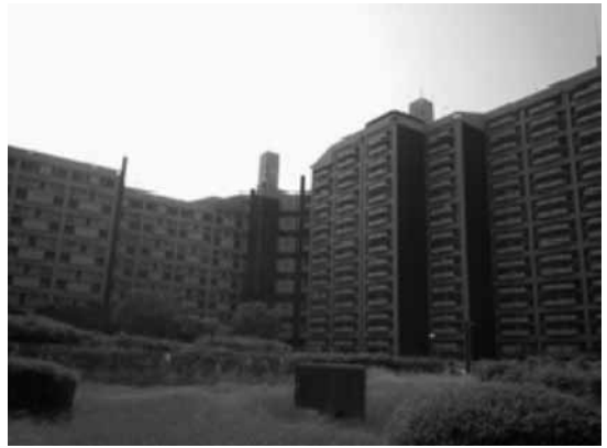
写真 5—8 囲まれた中央部にその屋上を緑地施設として設置された中央店舗（撮影：石丸紀興）
