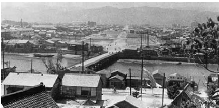
写真4ー2 比治山からみた建設中の百メートル道路（昭和27年5月12日）（広島市公文書館提供）
