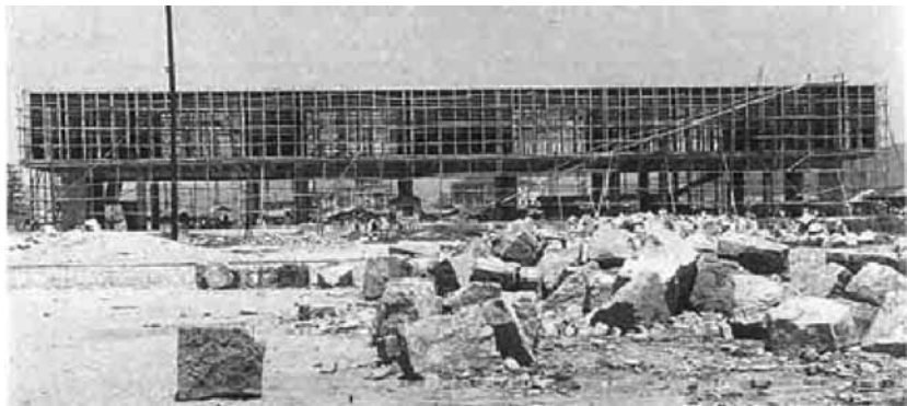
写真4—1 建設中の陳列館（昭和27年7月1日撮影）（広島市公文書館提供）
