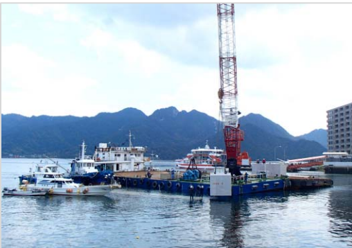
クレーン船による本体ブロック据付状況
