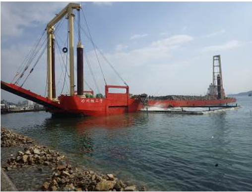
フェリーバージ船による基礎捨石投入状況
