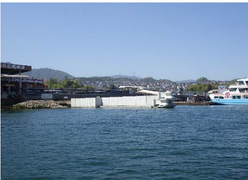
姿を現した仮締切護岸
