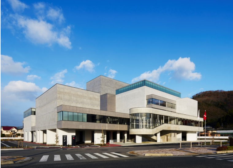
三次市民ホール きりり (広島県三次市)
