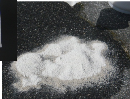
路上の油を吸収している様子
