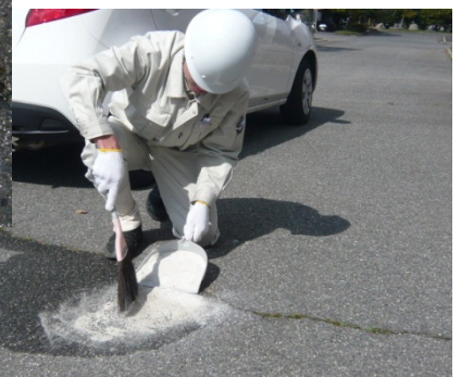
油吸着後の回収作業の様子
