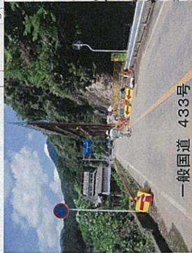
崩土撤去、仮設防護柵設置により
