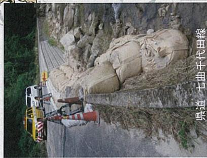
崩壊した路肩への大型土のう設置
