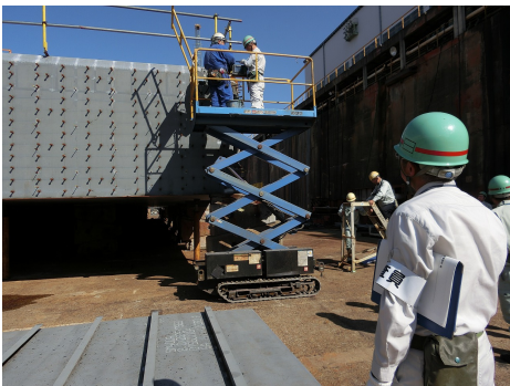
溶接部分は超音波等による検査を実施します
