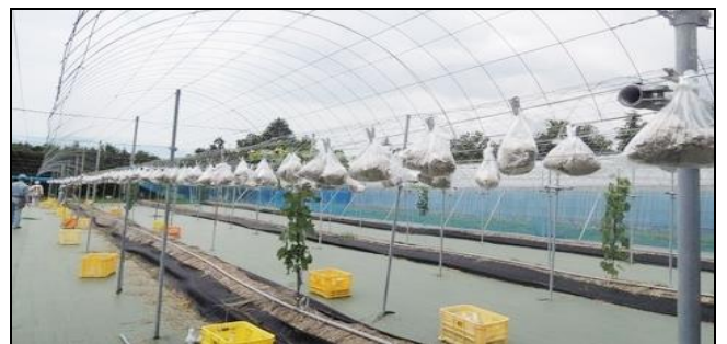
図2 砂袋の垂下による荷重の測定状況
